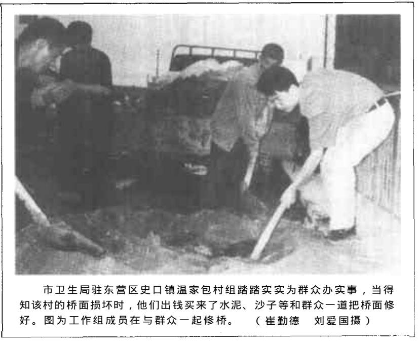
市卫生局驻东营区史口镇温家包村组踏踏实实为群众办实事，当得知该村的桥面损坏时，他们出钱买来了水泥、沙子等和群众一道把桥面修好。图为工作组成员在与群众一起修桥。(崔勤德 刘爱国摄)
